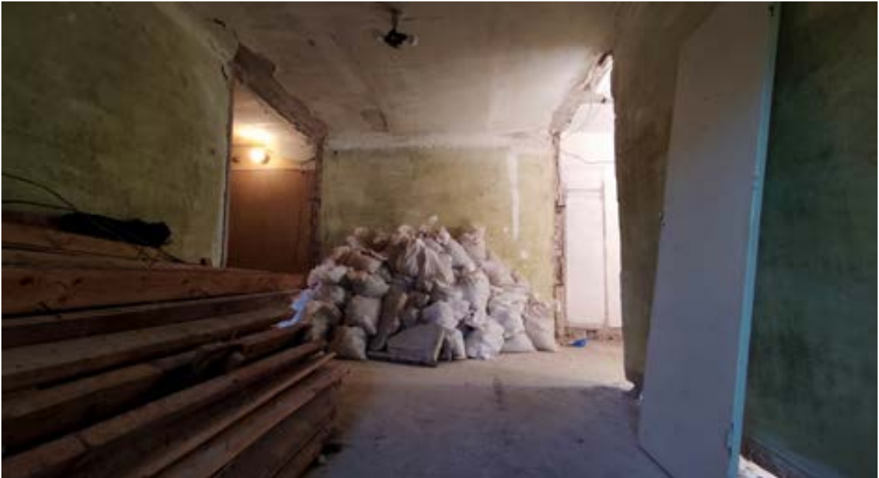
Imagen 13. ..... Acopio de residuos de construcción y demolición
