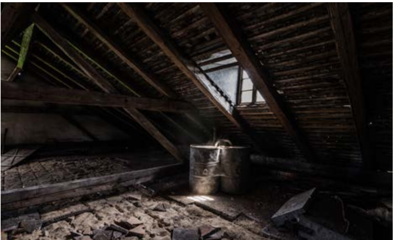
Imagen 14. ..... Demolición parcial bajo cubierta
